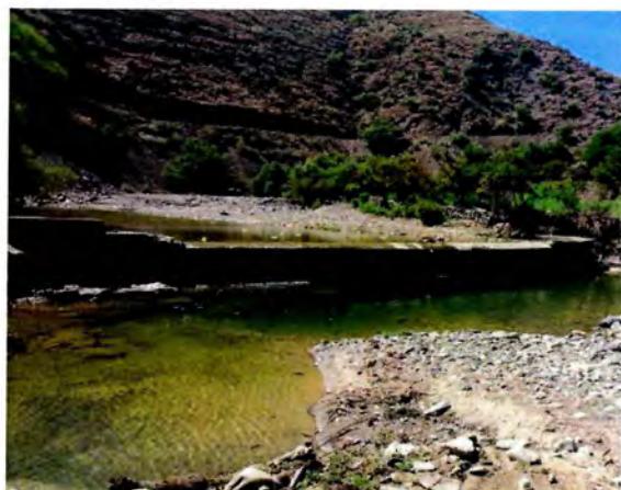
Obra de toma de agua para riego, río Trancas.
