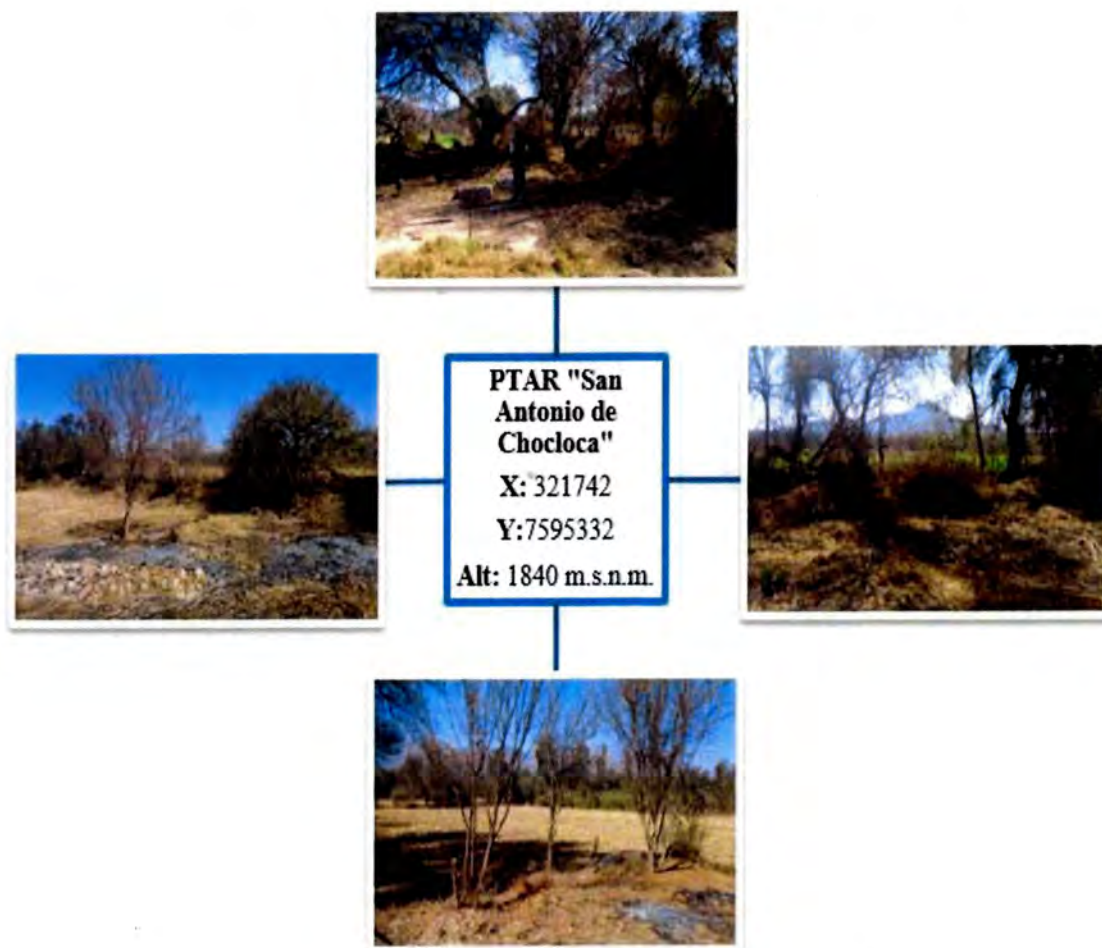
Figura 4.12. Sistema de tratamiento de aguas residuales de "San Antonio de Chocloca"
