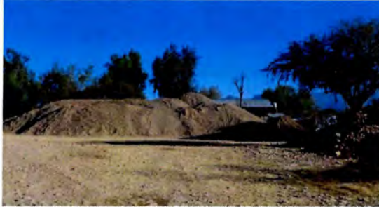
Ingreso a la planta procesadora de áridos Pimentel.
