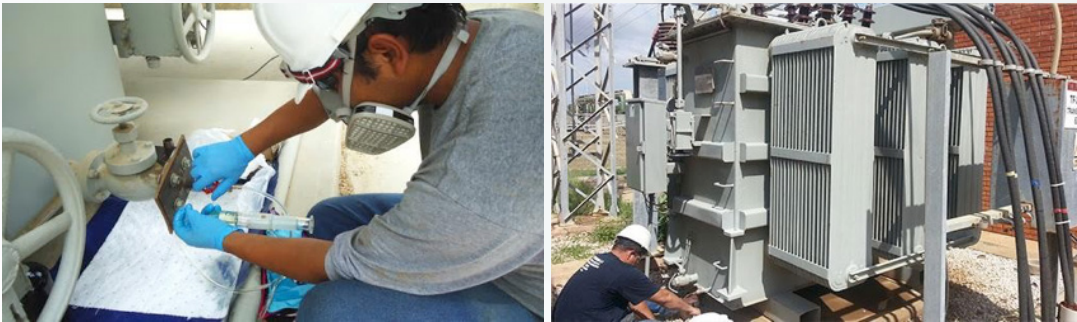
Fotografía 9. Trabajo de campo aplicando método para toma de muestras de salida de la válvula
