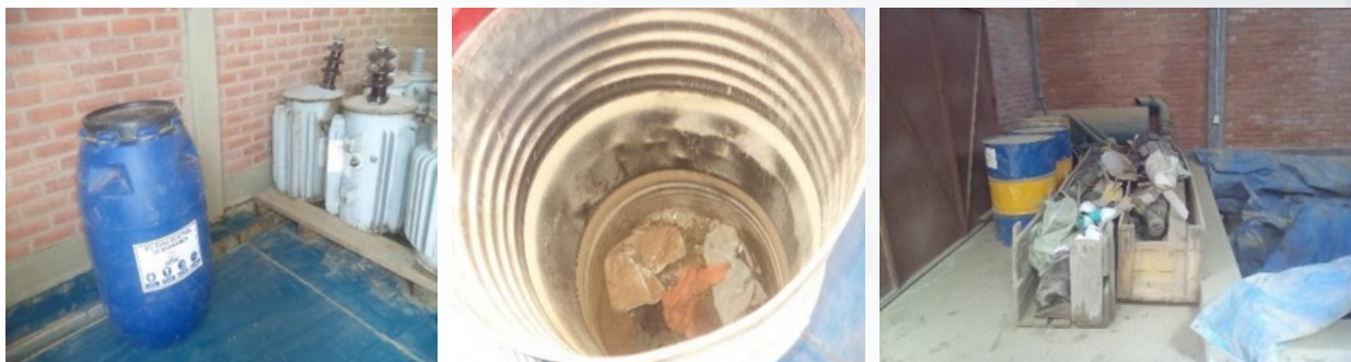
Fotografía 16. Disposición de Existencias con PCBs
