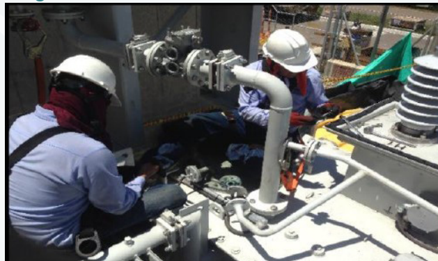
Fotografía 5. Tareas de mantenimiento de un Transformador
