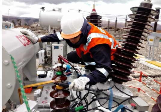
Fotografía 4. Trabajo de mantenimiento correctivo de un Transformador
