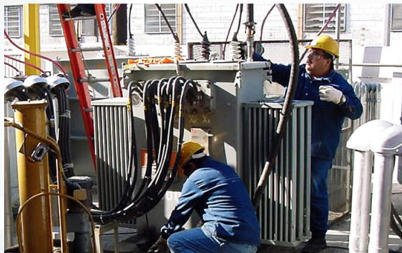
Fotografía 2. Trabajo de diagnóstico de un Transformado
