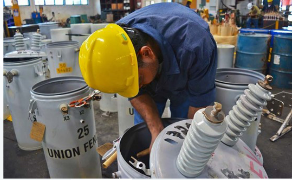
Fotografía 3. Trabajo de mantenimiento de un Transformador
