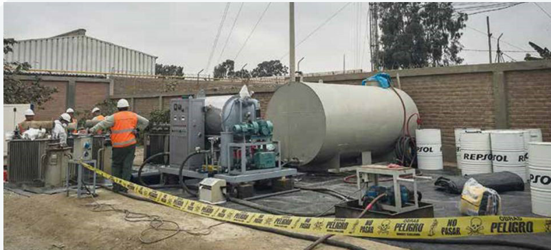
Imagen 11. Retrolenado empleando bombas
