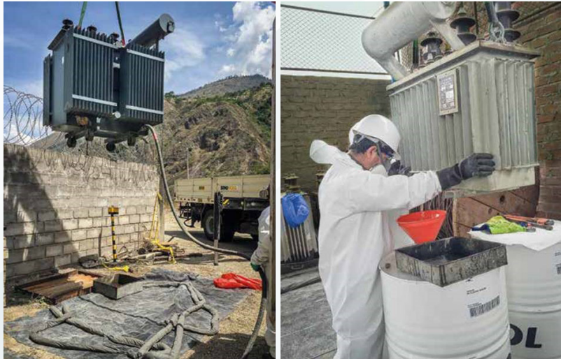
Imagen 10. Vaciado de aceite por gravedad
