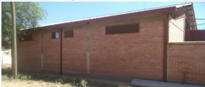
Figura 9. Paredes de ladrillo
